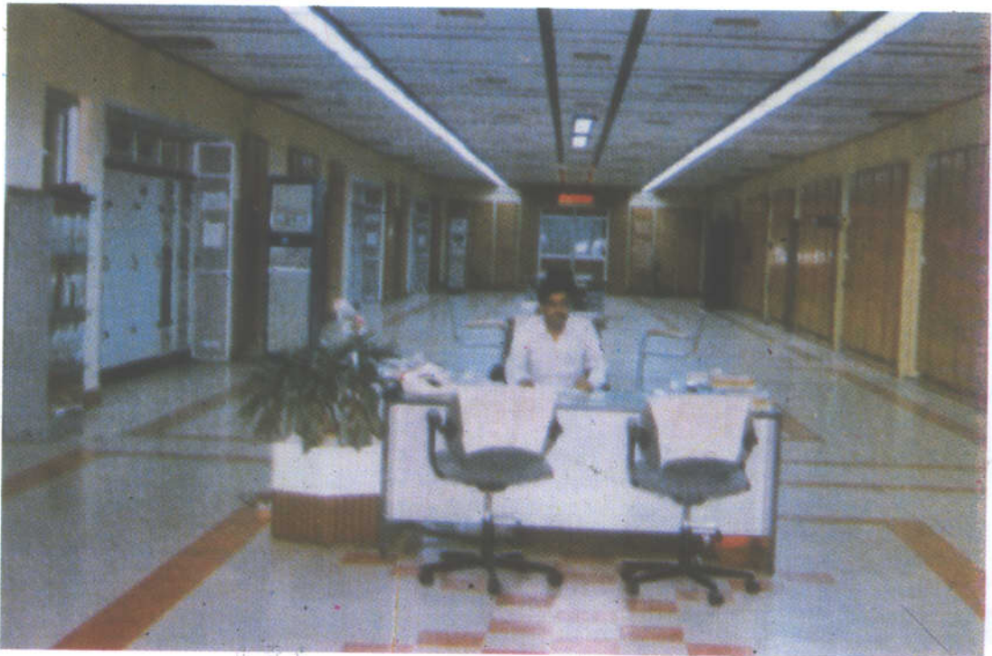
बंगलौर में आकाशवाणी के 4X500 किलोवाट शार्टवेव ट्रांसमीटर के ट्रांसमीटर हाल का एक दृश्य। यह विश्व में अपनी तरह का सबसे बड़ा ट्रांसमीटर है।
